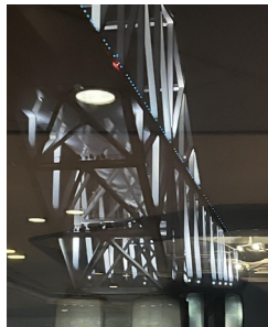
▼東京ゲートブリッジ
